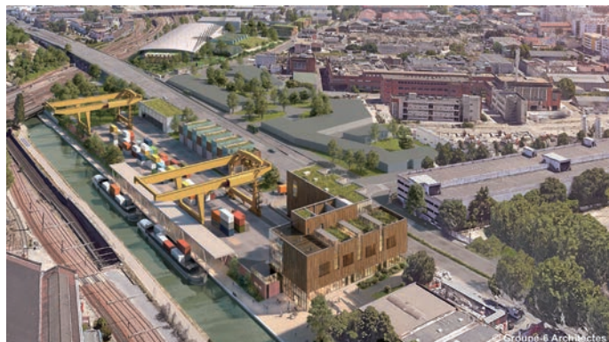
Aux travaux de modernisation des centres de transfert et de tri de Romainville/Bobigny, s'ajoute le développement d'un pôle dédié à l'économie circulaire.
