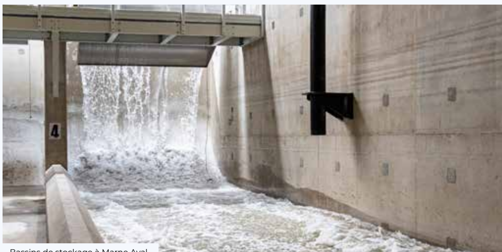
Bassins de stockage à Marne Aval
