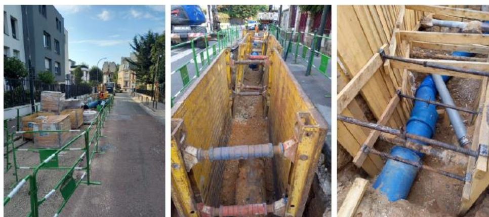
Renouvellement des canalisations DN 400 et DN 600 Rue Auguste Bailly à Asnières-sur-Seine
