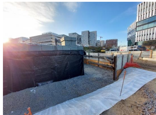
Remblaiement avec MISAPOR en cours par le département des Hauts-de-Seine
