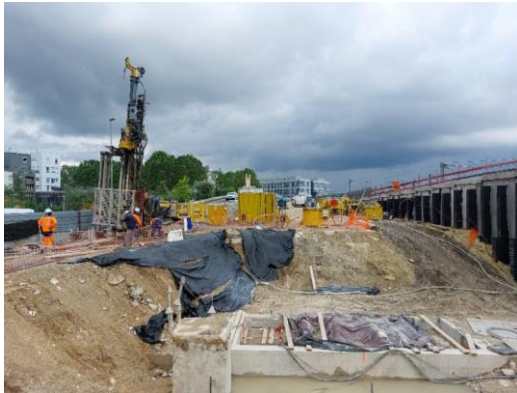
Forage en cours avant comblement de la carrière
