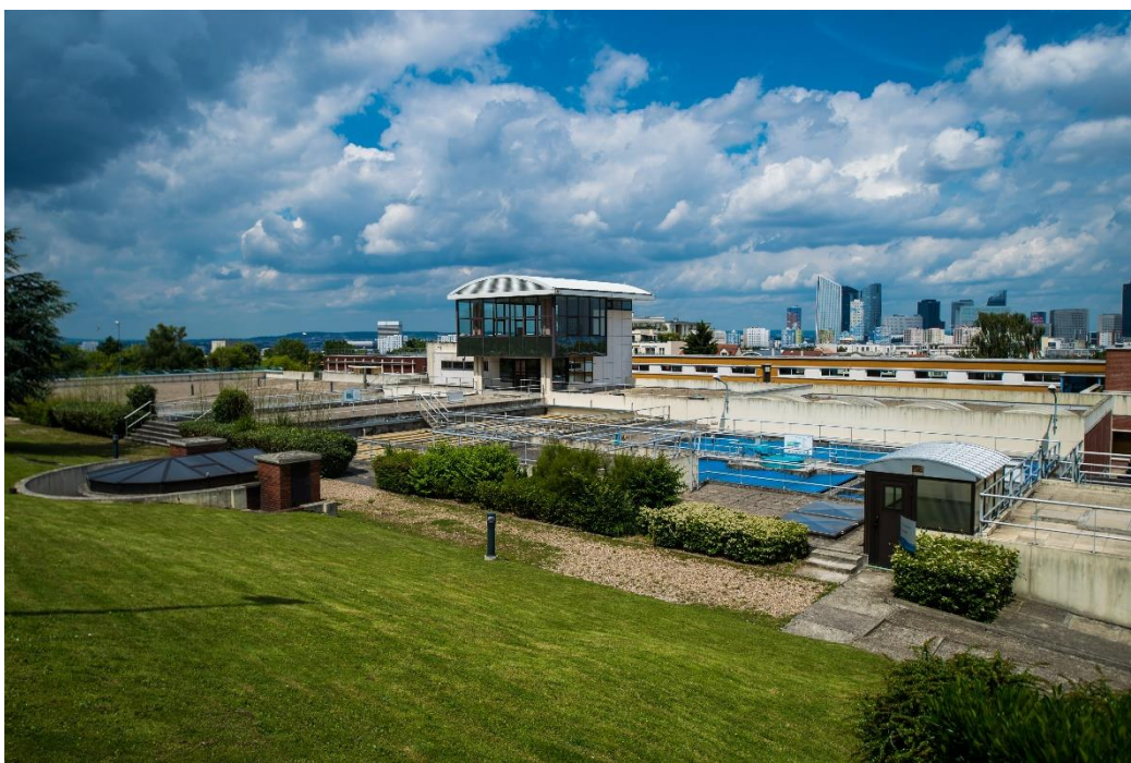
Vue de la station de traitement du Mont-Valérien
