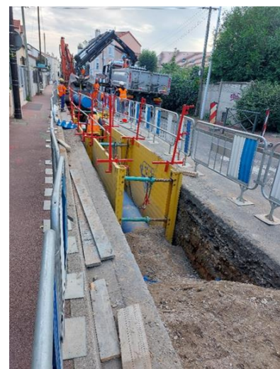
Travaux de renouvellement de la conduite de la rue des plaideurs à Nanterre – DN600 fonte
