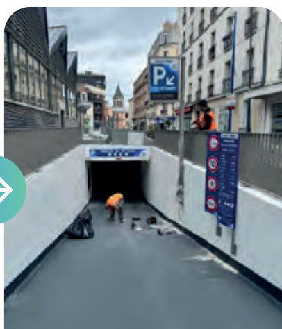
Installation des équipements de péage et de la signalétique
