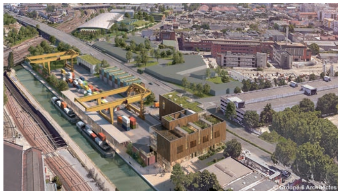
Aux travaux de modernisation des centres de transfert et de tri de Romainville/Bobigny, s'ajoute le développement d'un pôle dédié à l'économie circulaire.
