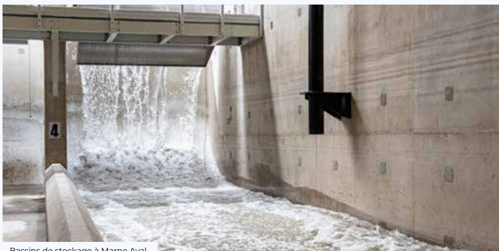
Bassins de stockage à Marne Aval
