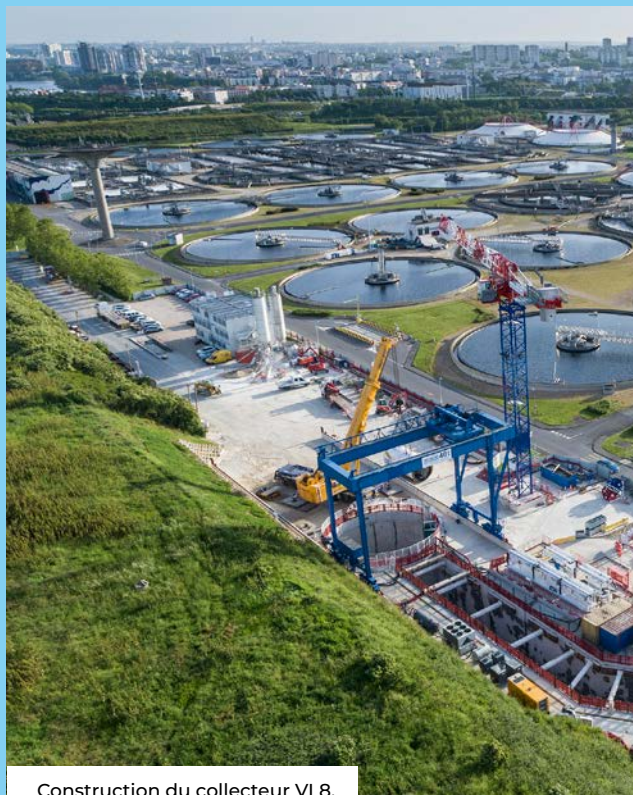
Construction du collecteur VL8.
