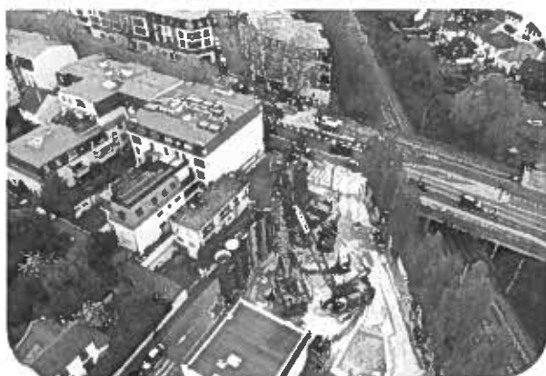
Figure 33 : Travaux de paroi moulée avant terrassement du bassin
