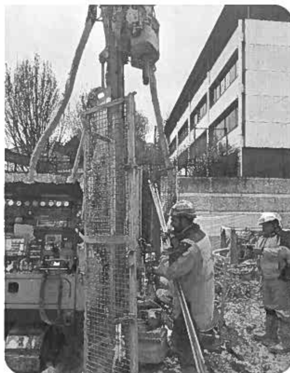
Figure 30 : Travaux de liaison au SAR 69 - Travaux de Jet Grouting
