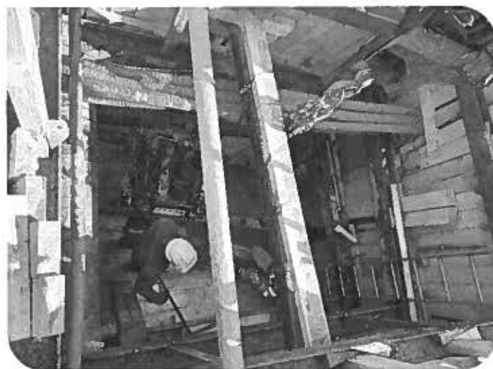
Figure 27 : Travaux de réhabilitation des branchements du collecteur visitable av. Général Leclerc à Bourg la Reine – Travaux de terrassement à l'aspiratrice et travaux de remplacement de branchements par forage horizontal à la tarière
