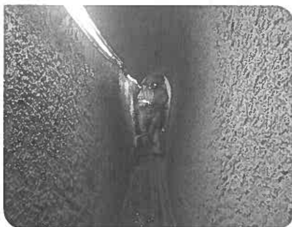
Figure 26 : Travaux de réhabilitation du collecteur visitable 190/100 rue de Chatenay à Antony – Ferrillage et projection de mortier
