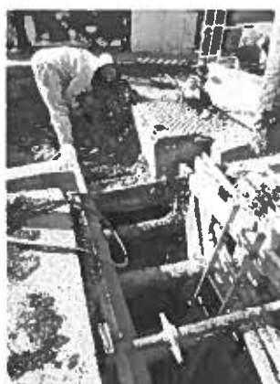
Figure 20 : Travaux de renouvellement du branchement effondré 23 route des Gardes à Meudon
