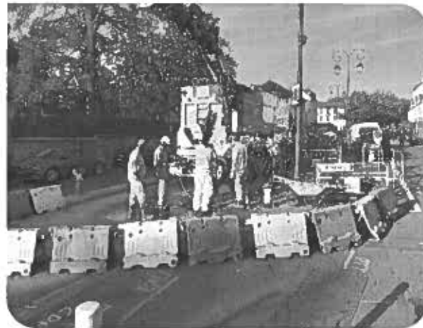
Figure 24 : Travaux de renouvellement des branchements en tranchée ouverte avec des terrassement réalisés principalement à l'aspiratrice rue Maurice Labrousse à Antony
