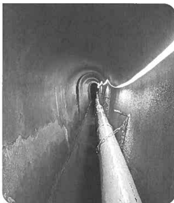
Figure 25 : Travaux de réhabilitation du collecteur visitable 190/100 rue de Chatenay à Antony – Mise à sec et éclairage
