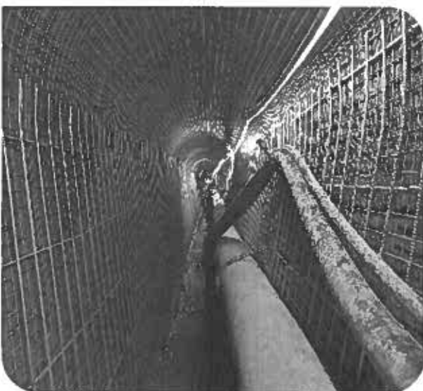
Figure 26 : Travaux de réhabilitation du collecteur visitable 190/100 rue de Chatenay à Antony – Ferrillage et projection de mortier
