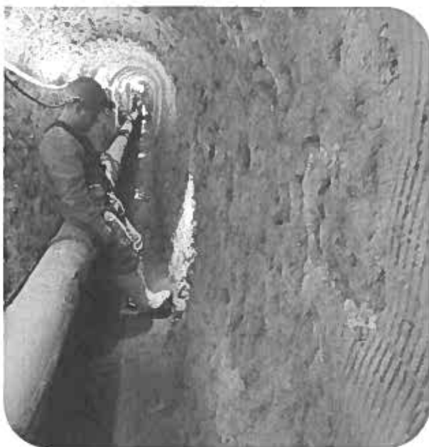
Figure 28 : Travaux de réhabilitation du collecteur visitable av. Général Leclerc à Bourg la Reine – Centrale d'injection
