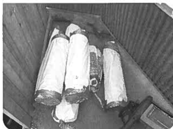
Figure 19 : Travaux de dépose soignée par une entreprise agréée du branchement effondré en amiante ciment 118 av. Aristide Briand à Antony
