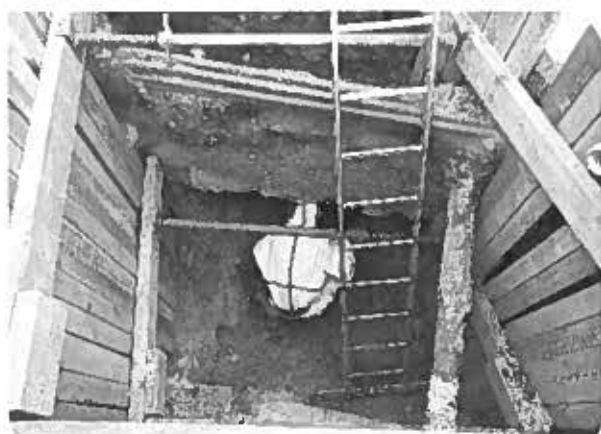
Figure 19 : Travaux de dépose soignée par une entreprise agréée du branchement effondré en amiante ciment 118 av. Aristide Briand à Antony
