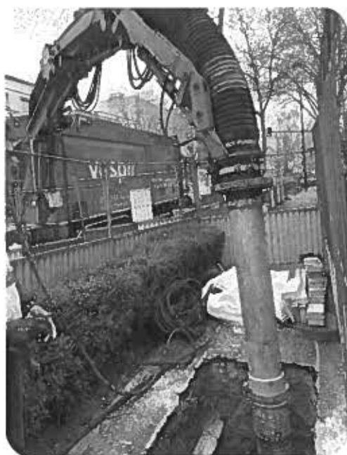
Figure 27 : Travaux de réhabilitation des branchements du collecteur visitable av. Général Leclerc à Bourg la Reine – Travaux de terrassement à l'aspiratrice et travaux de remplacement de branchements par forage horizontal à la tarière
