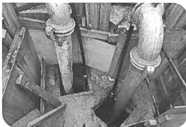
Figure 29 : Travaux de réhabilitation du collecteur visitable de quai sous le PDZ Station de pompage
