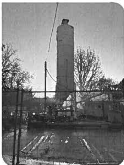
Figure 35 : Travaux d'injection de terrain avant les terrassements
