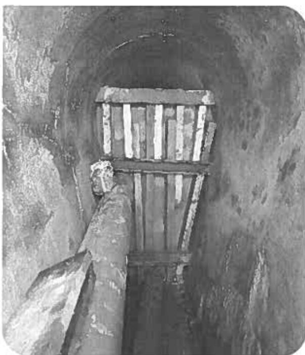
Figure 25 : Travaux de réhabilitation du collecteur visitable 190/100 rue de Chatenay à Antony – Mise à sec et éclairage
