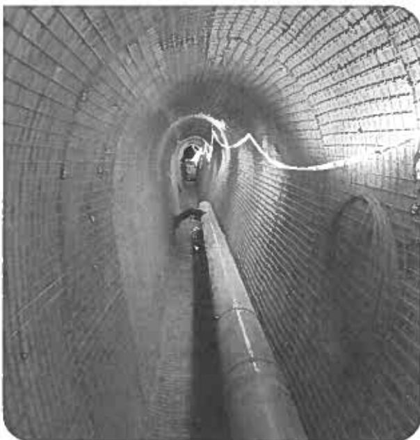
Figure 28 bis : Travaux de réhabilitation du collecteur visitable av. Général Leclerc à Bourg la Reine – Chemisage par béton projeté armé
