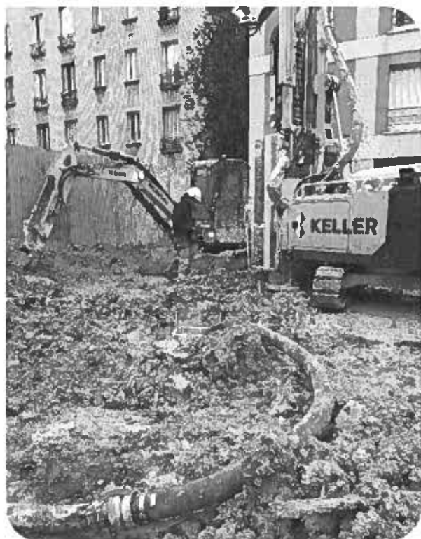
Figure 30 : Travaux de liaison au SAR 69 - Travaux de Jet Grouting
