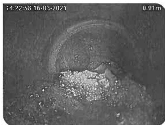
Figure 20 : Travaux de renouvellement du branchement effondré 23 route des Gardes à Meudon
