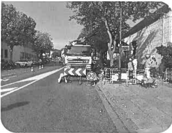
Figure 24 : Travaux de renouvellement des branchements en tranchée ouverte avec des terrassement réalisés principalement à l'aspiratrice rue Maurice Labrousse à Antony
