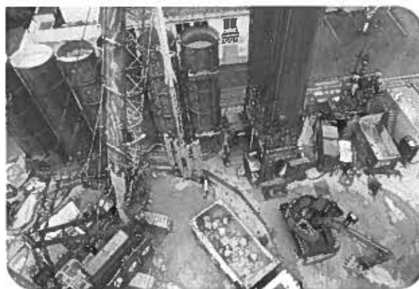
Figure 33 : Travaux de paroi moulée avant terrassement du bassin
