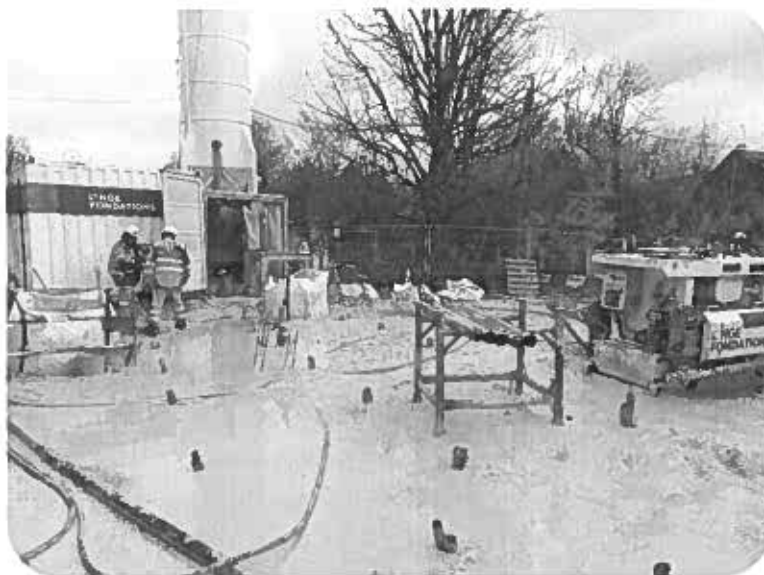
Figure 35 : Travaux d'injection de terrain avant les terrassements
